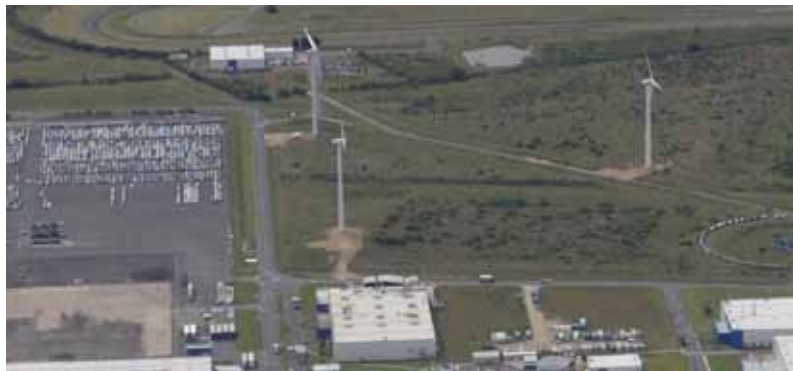
Développement en ponctuation - Usine Nissan - GB
